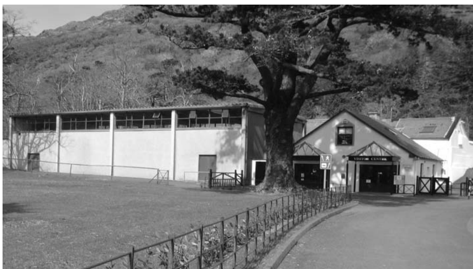
Die „Turnhallen-Kirche“ in der Außenansicht
